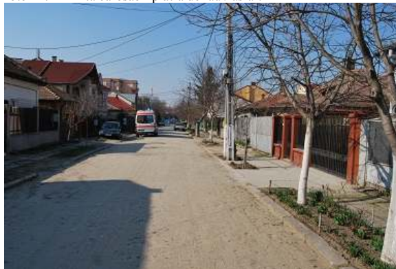
Foto 42.2 Limita carosabil piatră de râu / asfalt
