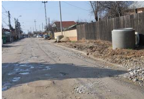
Foto 74.2 Asfalt deteriorat
