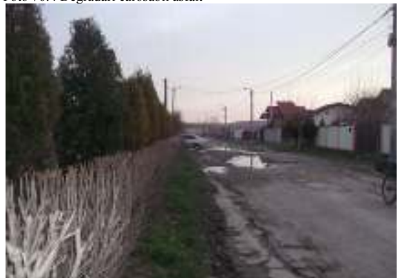
Foto 76.4 Degradari carosabil asfalt
