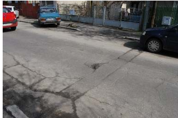
Foto 25.4 Plombe deteriorate
