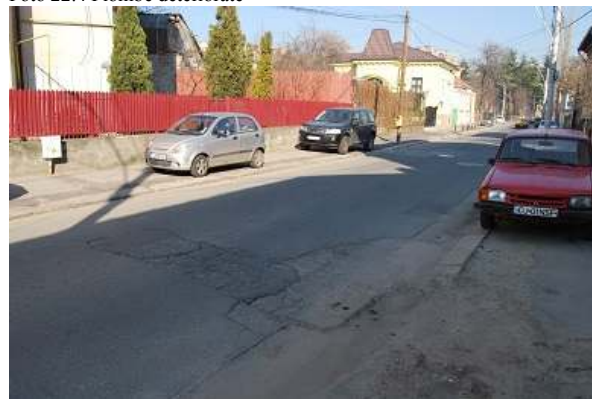
Foto 22.4 Plombe deteriorate
