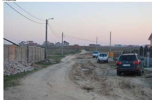
Foto 62.1 vedere din str. Vanatori de Munte
