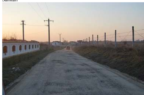
Foto 4.2 vedere spre str.Eroii Sanitari
