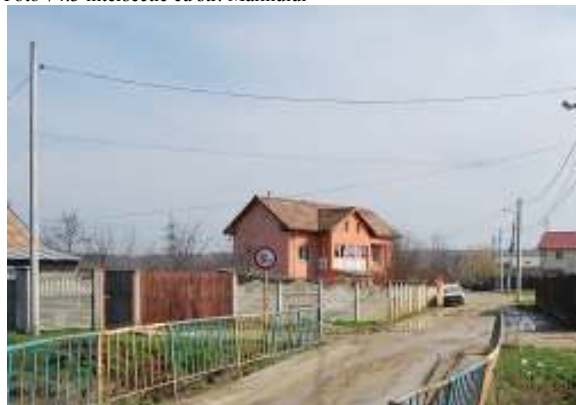
Foto 74.3 intersecție cu str. Malinului
