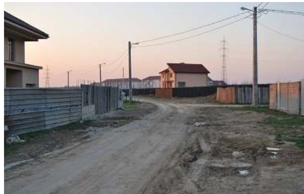
Foto 14.2 Detaliu tronson situate la est de str. Artileriei
