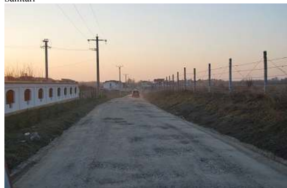
Foto 4.2 vedere spre str.Eroii Sanitari
