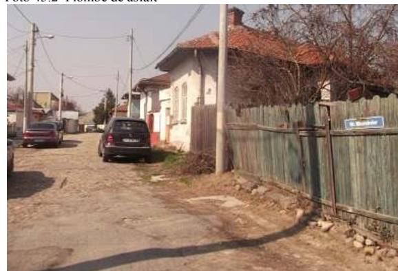
Foto 45.2 Plombe de asphalt
