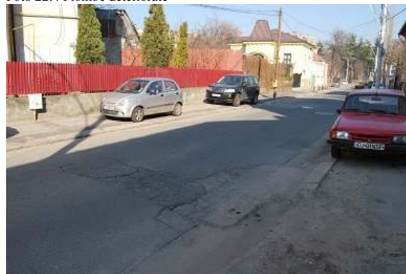
Foto 22.4 Plombe deteriorate
