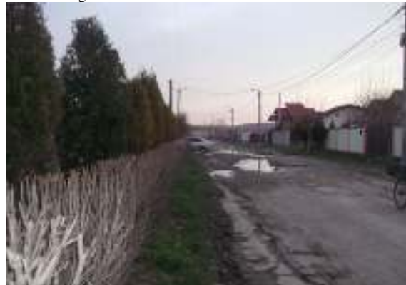
Foto 76.4 Degradari carosabil asfalt
