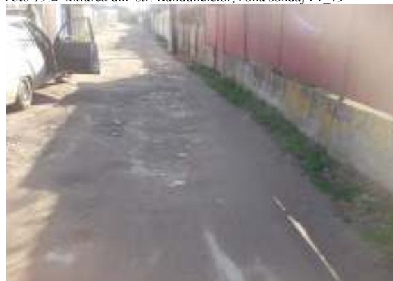
Foto 79.2 intrarea din str. Rândunelelor, zona sondaj F1_79
