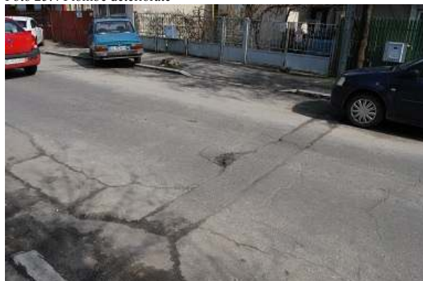
Foto 25.4 Plombe deteriorate
