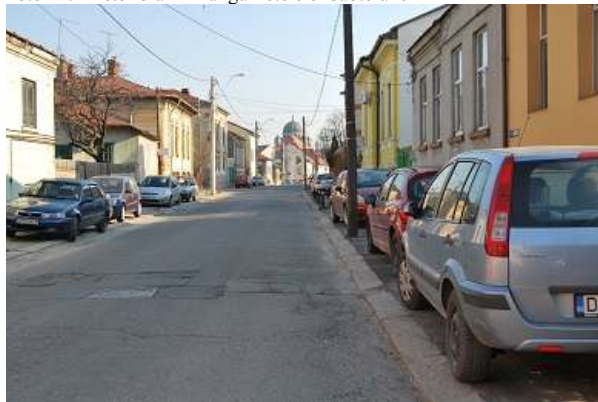
Foto 22.1 Deteriorari in lungul retelelor subterane
