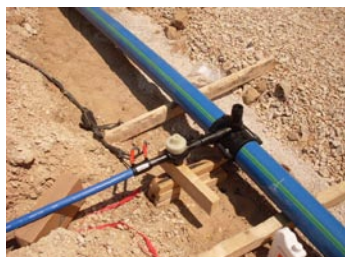
Conectarea conductei de bransament la reseaua publica prin intermediul prizei de apa, si vana de concesi
