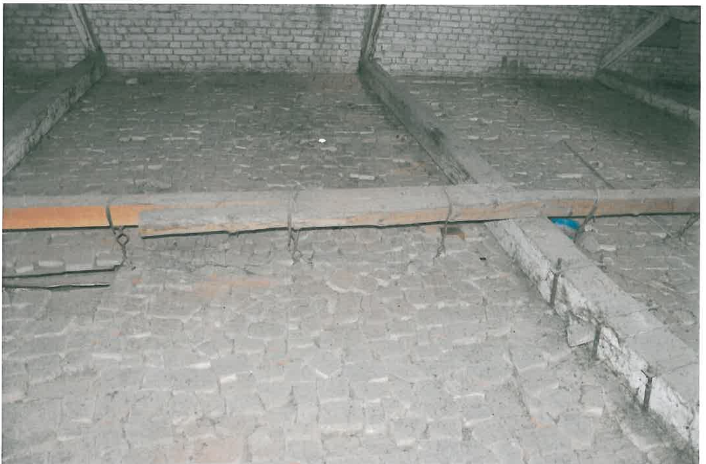
TERMOIZOLAȚIE PLANȘEU ȘI GRINZI AJUTĂTOARE PENTRU SUSȚINEREA GRINZILOR PLANȘEULUI
