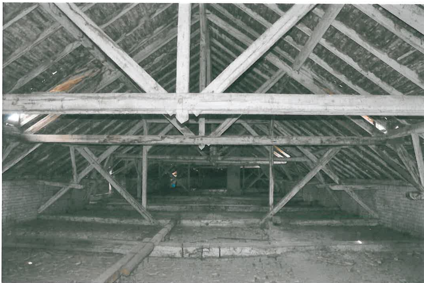
FERME STRUCTURĂ ȘARPANTĂ
