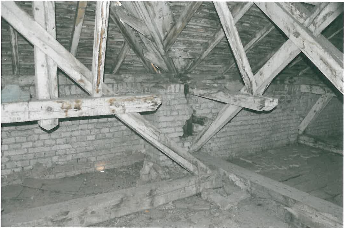
POPI DE LEMN ÎNGLOBAȚI ÎN PARAPETUL PERIMETRAL DE ZIDĂRIE AL PODULUI
