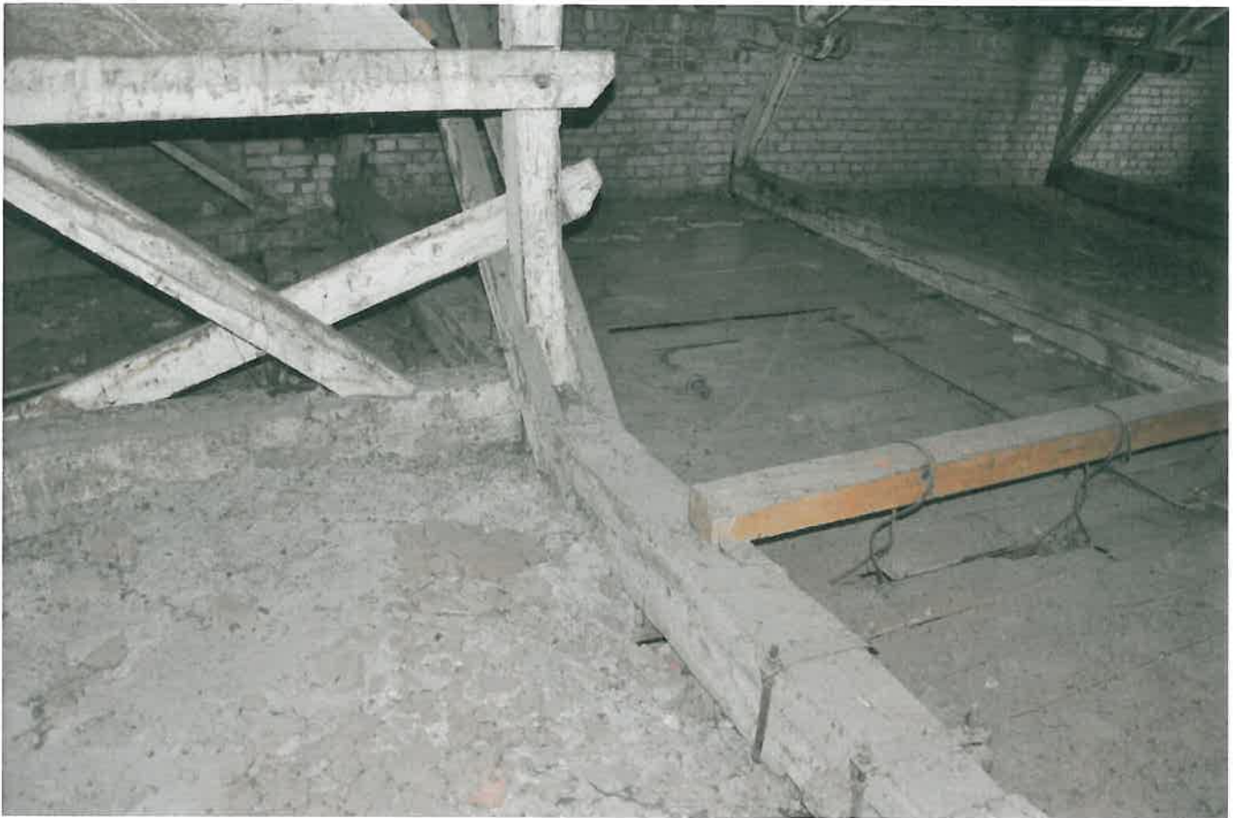
GRINZI AJUTĂTOARE PENTRU SUSȚINEREA GRINZILOR PLANȘEULUI
