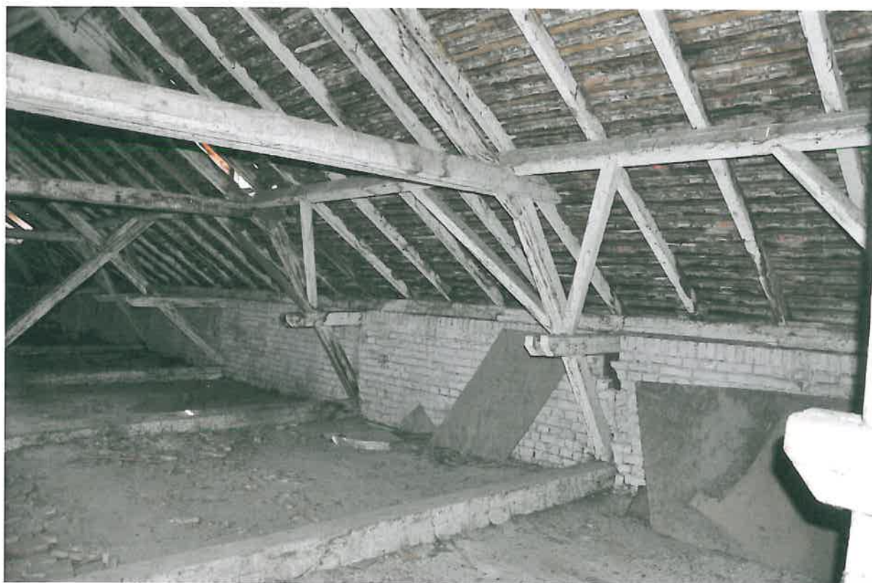
POPI ÎNGLOBAȚI ÎN PARAPETUL PERIMETRAL DIN ZIDĂRIE
