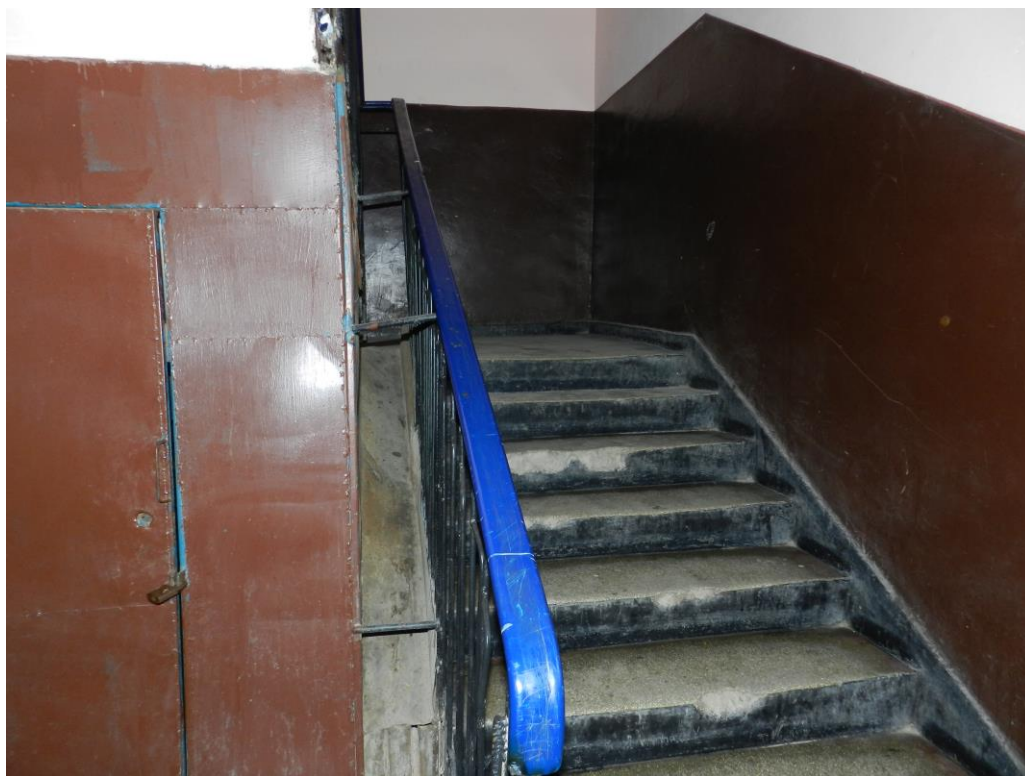
Foto.10 Scari interioare rupte
