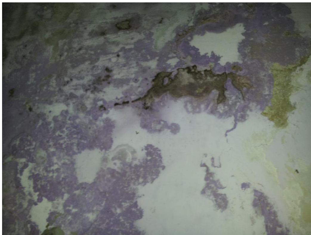
Foto.7 Fisuri si tencuieli degradate – planseu grupuri sanitare si uscatorie
