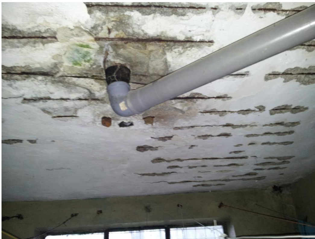
Foto.7 Fisuri si tencuieli degradate – planseu grupuri sanitare si uscatorie
