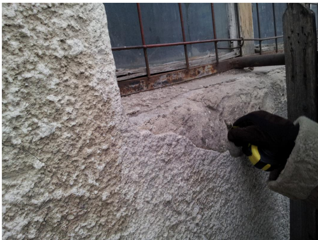
Foto.3 Tencuieli degradate la peretii exteriori
