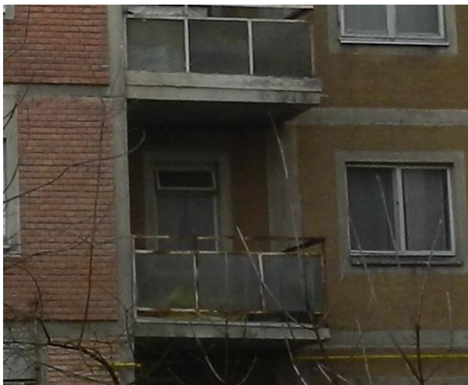
Foto.4 Balcoane cu parapeti din sticla
