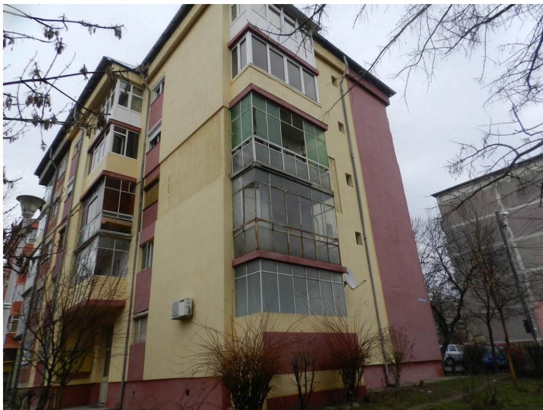
Foto.1 Fatada posterioara si laterala stanga; balcoane cu parapeti din sticla
