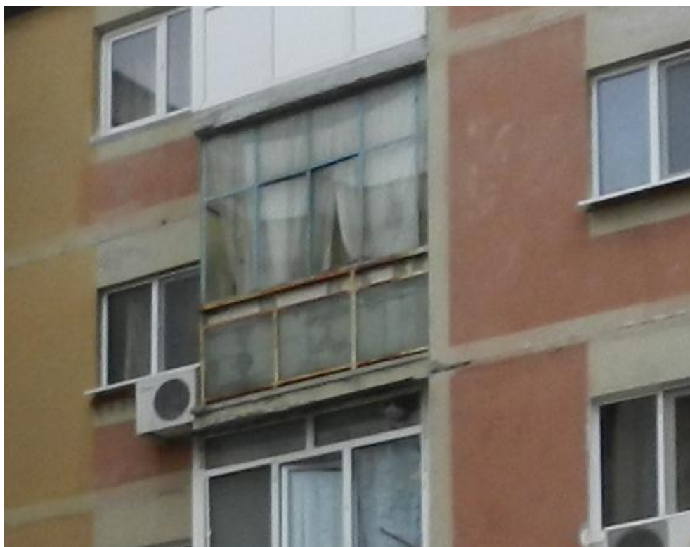
Foto.2 Balcoane cu parapeti din sticla
