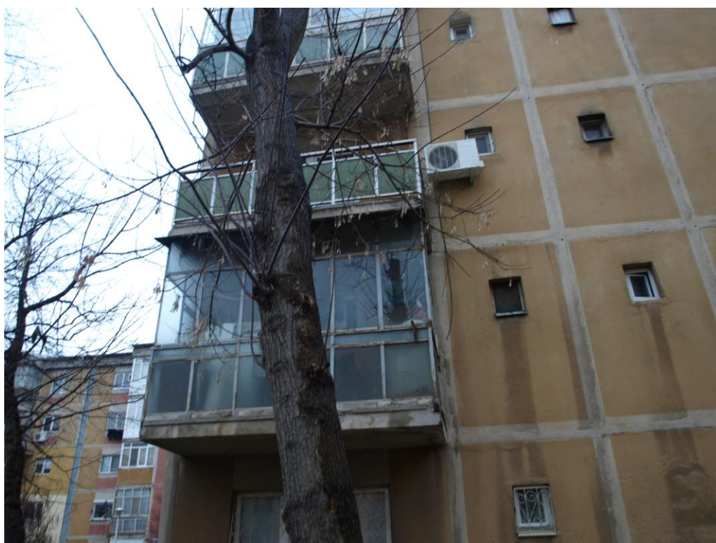
Foto.2 Fatada laterala stanga scara1; parapeti din sticla la balcoane
