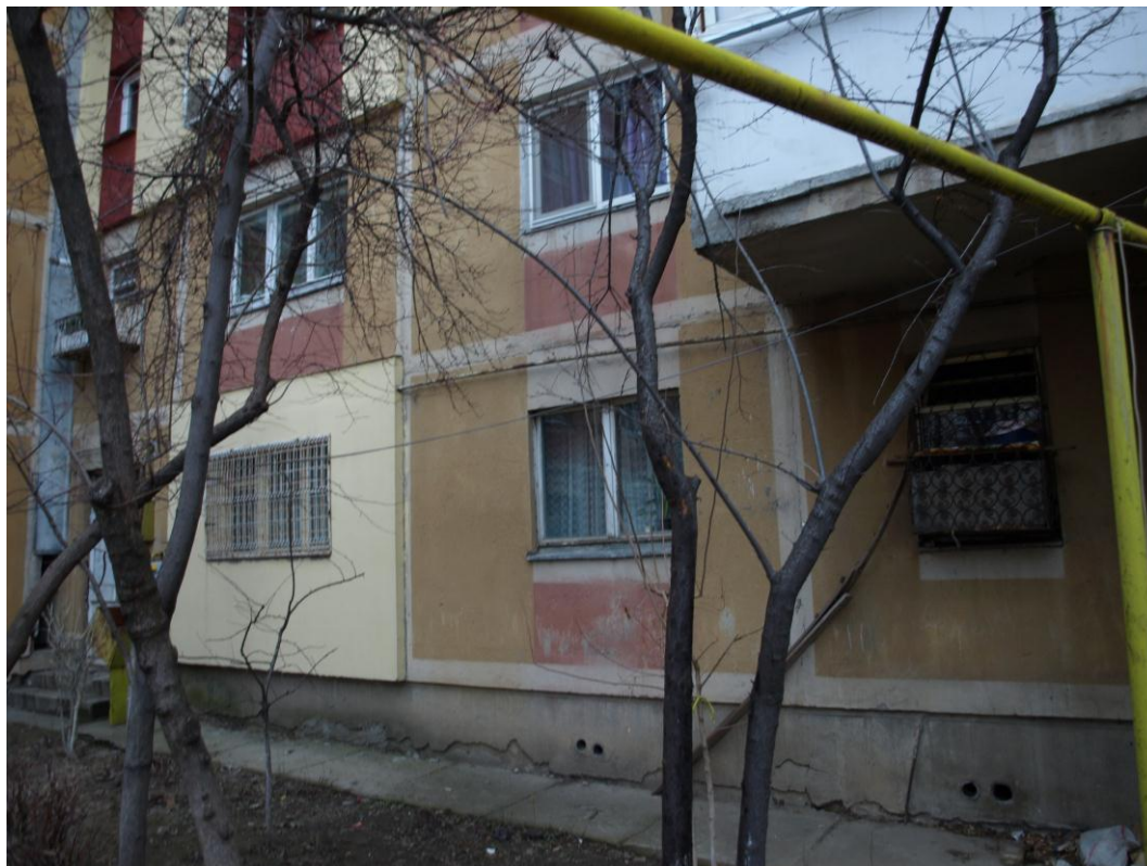
Foto.4 Tencuieli degradate la soclu; trotuar tasat
