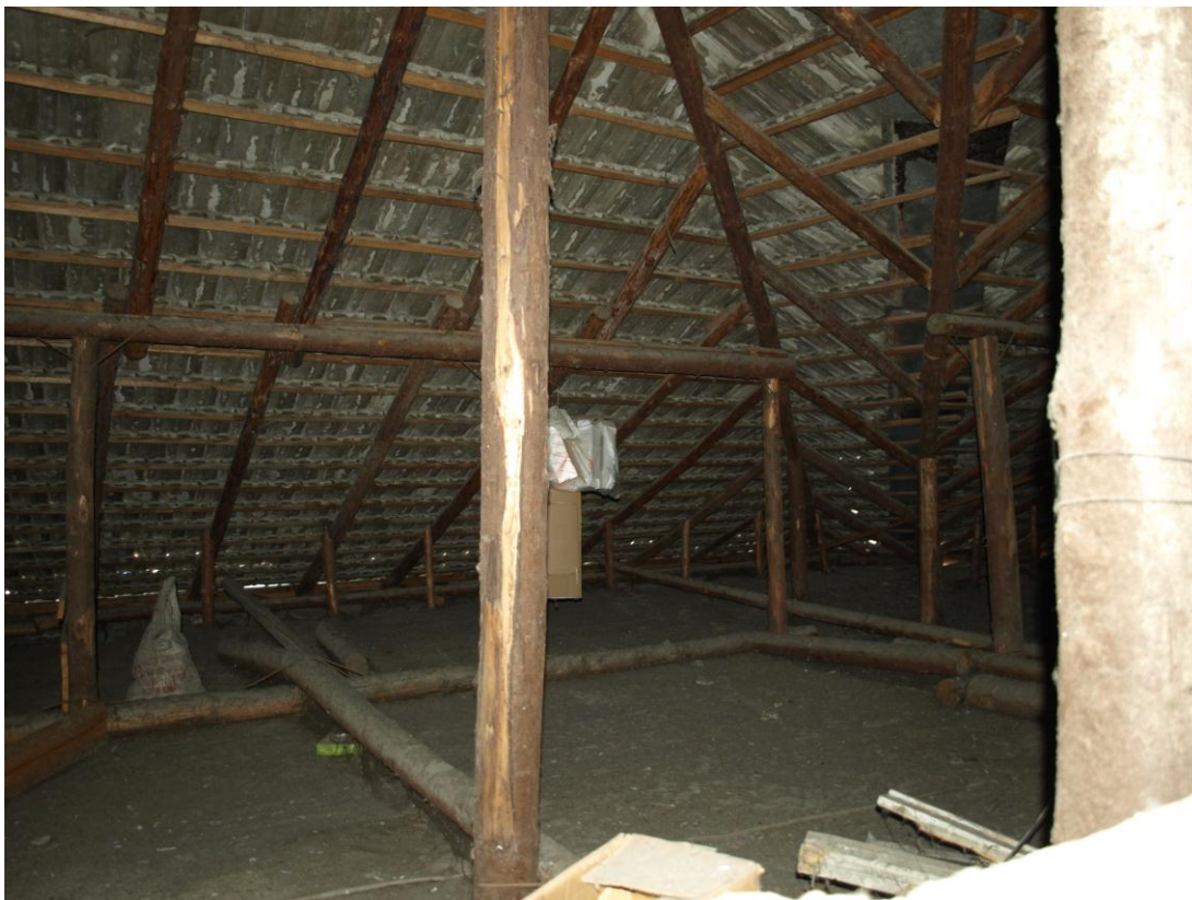
Foto.8 Popi sarpanta rezemati direct pe planseu; contrafise si clesti lipsa
