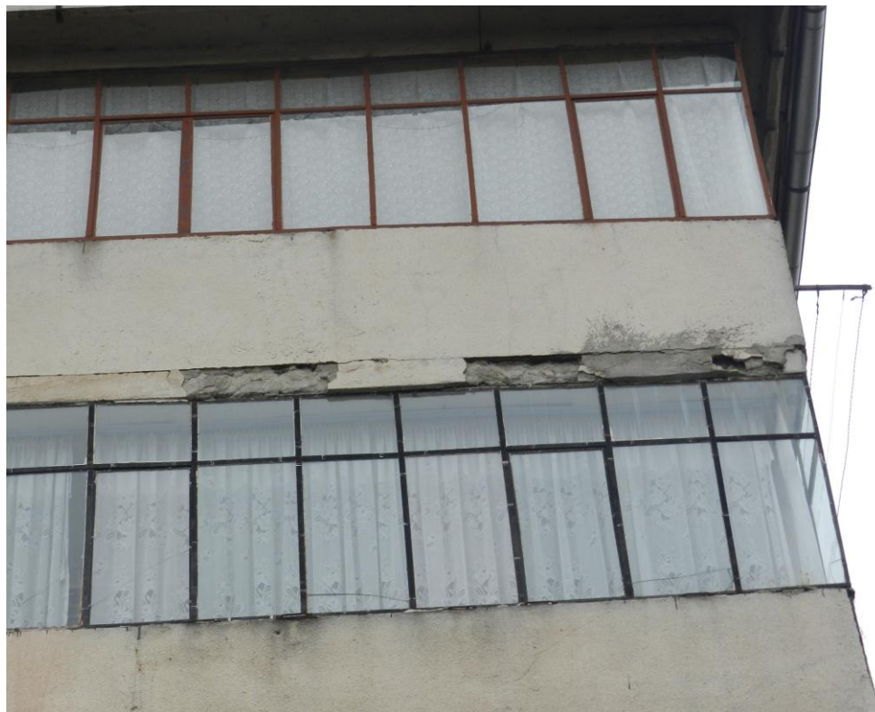
Foto.3 Degradari parapet balcon
