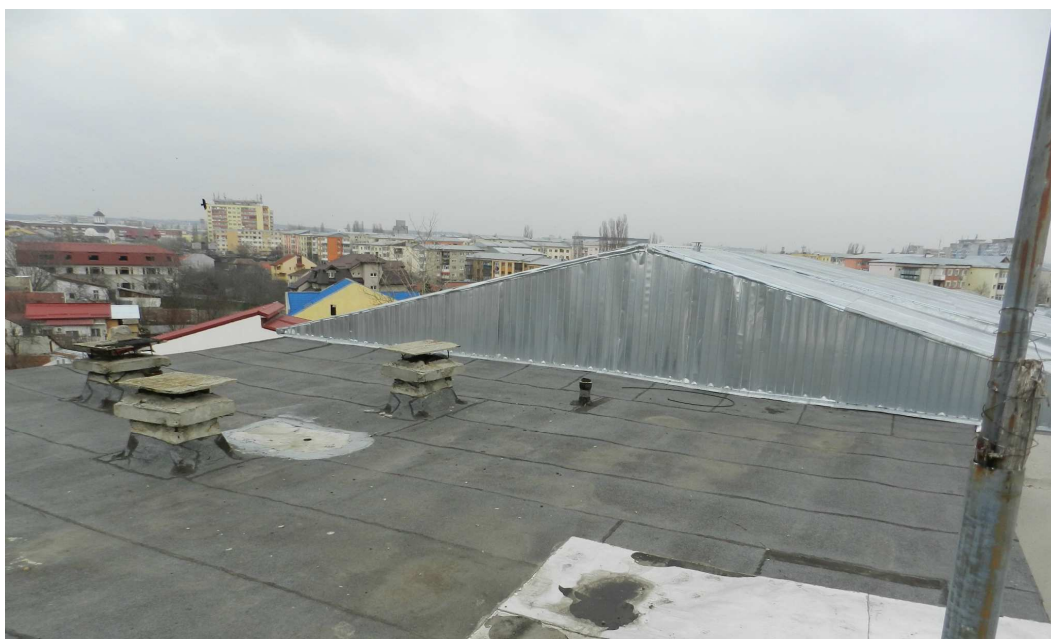
Foto.3 Sarpanta din lemn cu invelitoare din tabla
