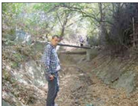
Foto 2- Tronson deschis betonat (cca. 15 m)
