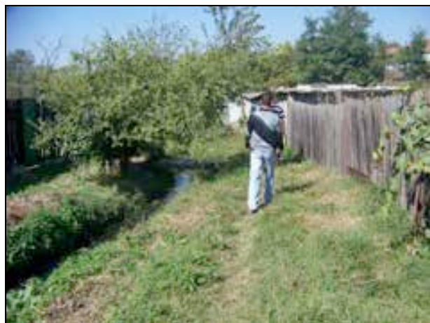
Foto 5 - Tronson deschis din pamant(Str. Alunului) Foto 6 – Final tronson Str. Alunului
