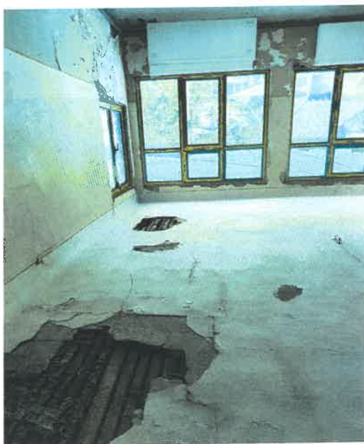
Relevee foto: Starea tehnica a constructiei:
