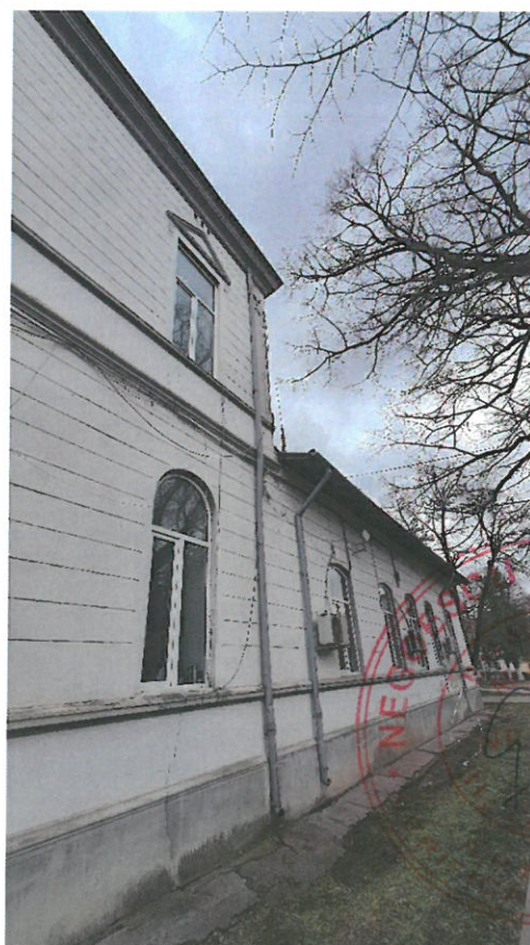
Figura 5 Deteriorarea și tasarea diferentiată a trotuarului. Burlane nefuncționale;
