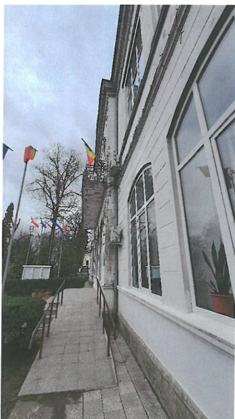
Figura 5 Deteriorarea și tasarea diferentiată a trotuarului. Burlane nefuncționale;
