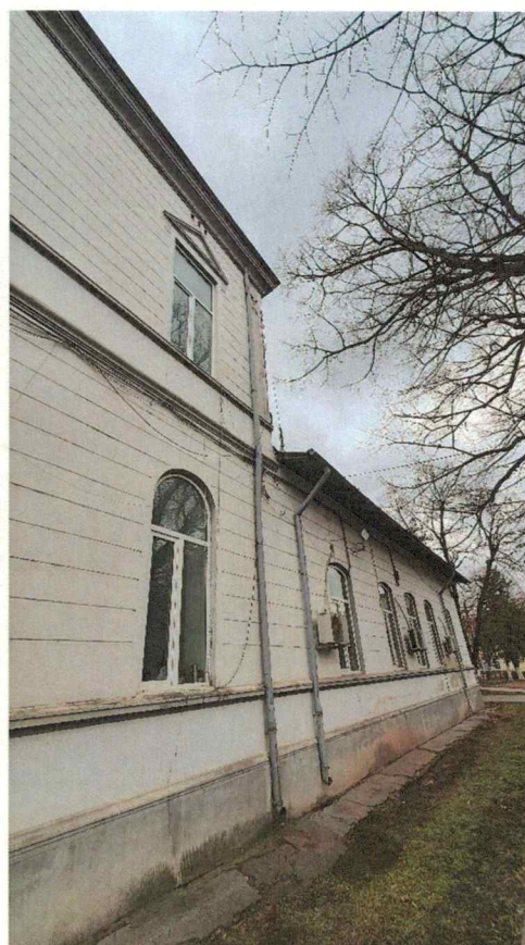
Figura 3 Deteriorarea și tasarea diferentiată a trotuarului. Burlane nefuncționale;
