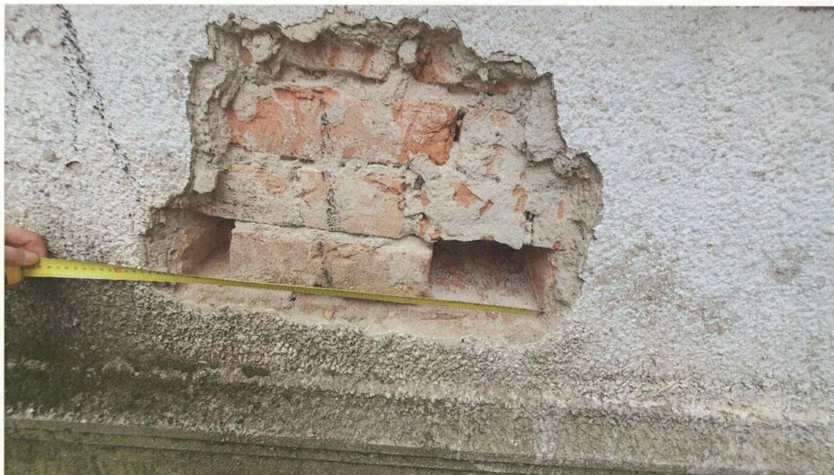
Figura 81: Zone de prelevare de probe, respectiv incercari de forfecare in rost;
