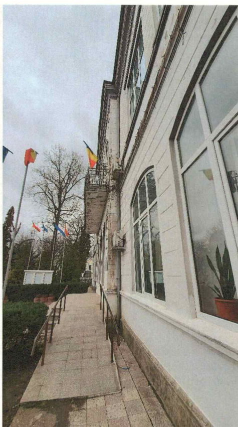
Figura 3 Deteriorarea și tasarea diferentiată a trotuarului. Burlane nefuncționale;
