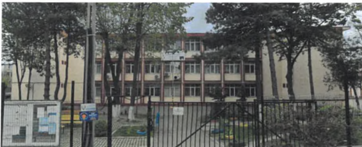
Figura 1 – Fațada Nord-Vest, către stradă
