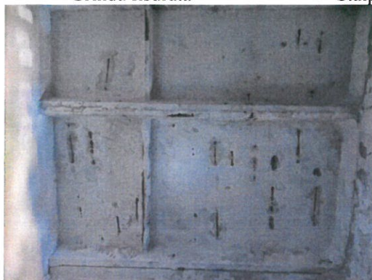
Chesoane cu armătura la Vedere
