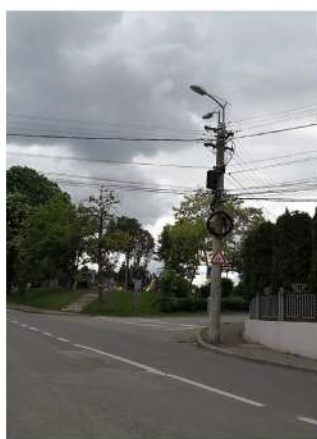
Acces dinspre strada Calarasilor
