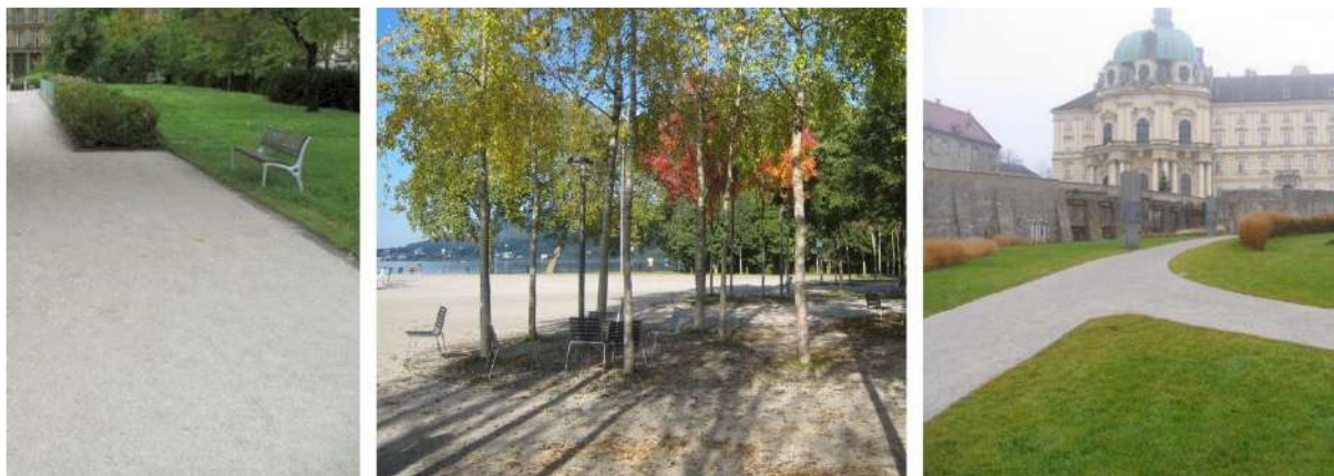
Figura 18 – Suprafață de călcare din agregate naturale stabilizate
