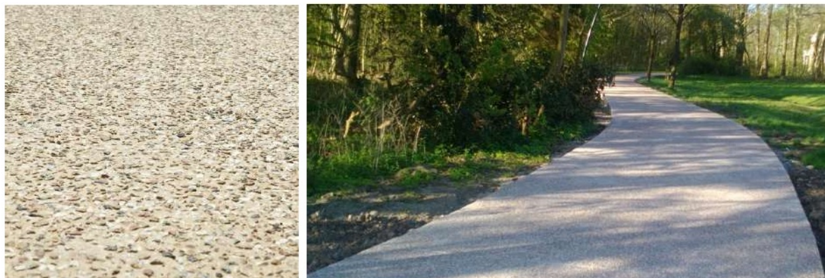
Figura 17 – Suprafață de călcare din beton dezactivat (agregate expuse)
