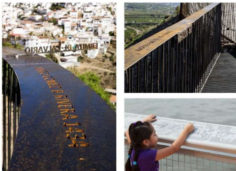
Figura 21 – Parapeți ornamentali și cu rol signalistic
