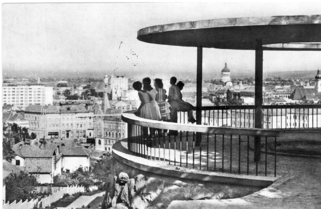
Figura 23 – Restaurarea pavilionului rotonda
