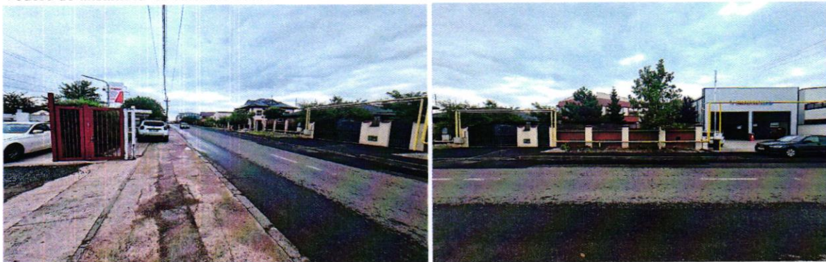
Vedere de ansamblu la calea de acces
