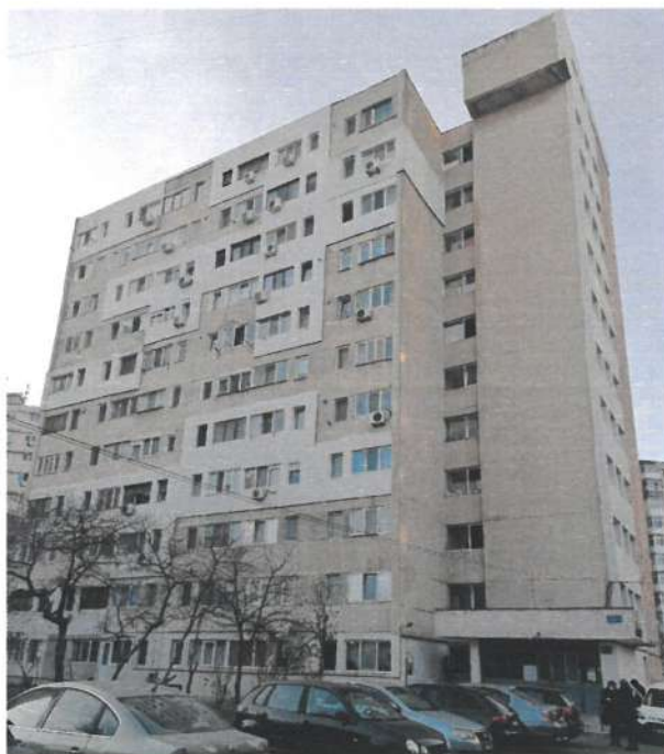
Figura 1 – Fațada principală SUD-EST.
