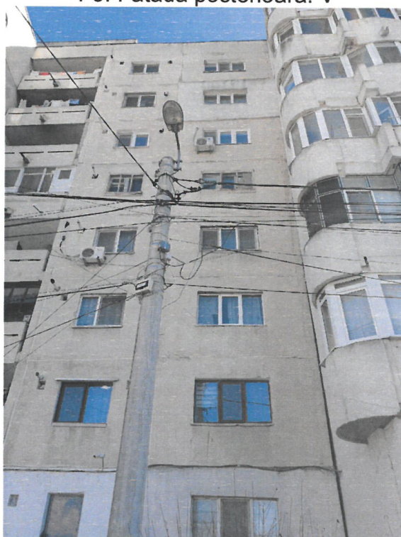
F4. Fatada posterioara V (zona de rost cu Blocul 26A)
