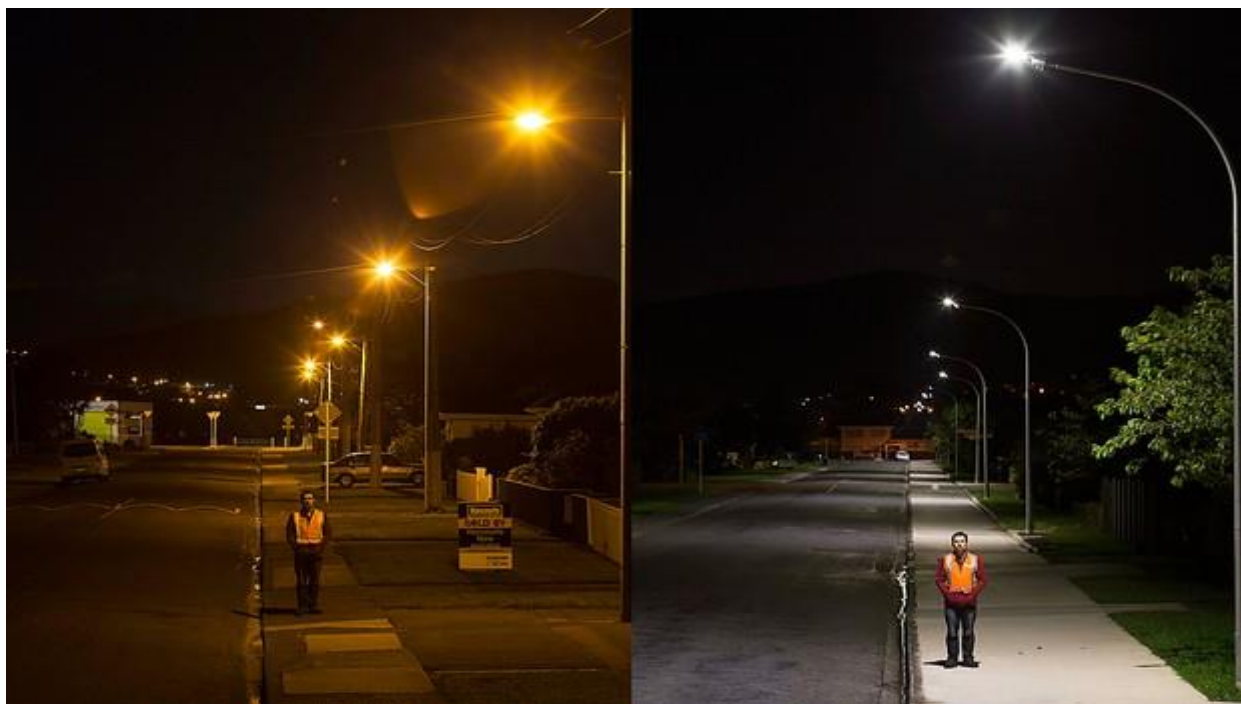
Fig. 1.2. Comparatie intre sistem de iluminat cu vapori de sodiu de inalta presiune si sistem de iluminat cu LED
