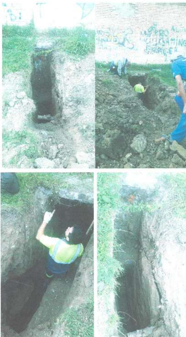
Foto: Efectuarea sondajelor – Sala Polivalentă
