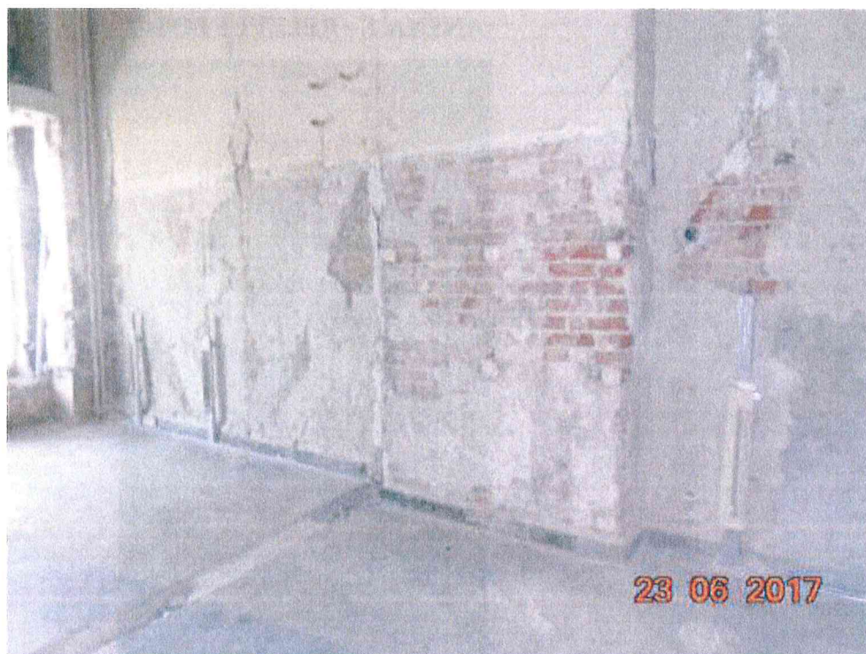
Foto 3 – tencuieli degradate si fisuri in peretii din zidarie
