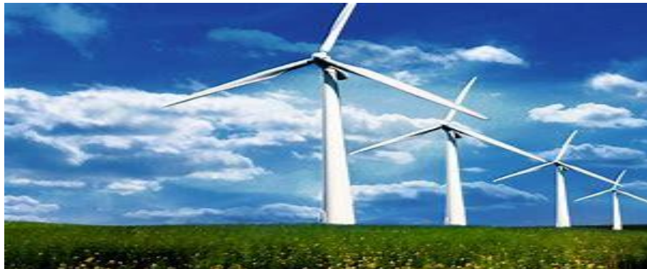
Imagine nr. 10 – Centrale eoliene
