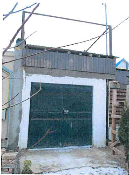
Vedere stradala C1-garaj
