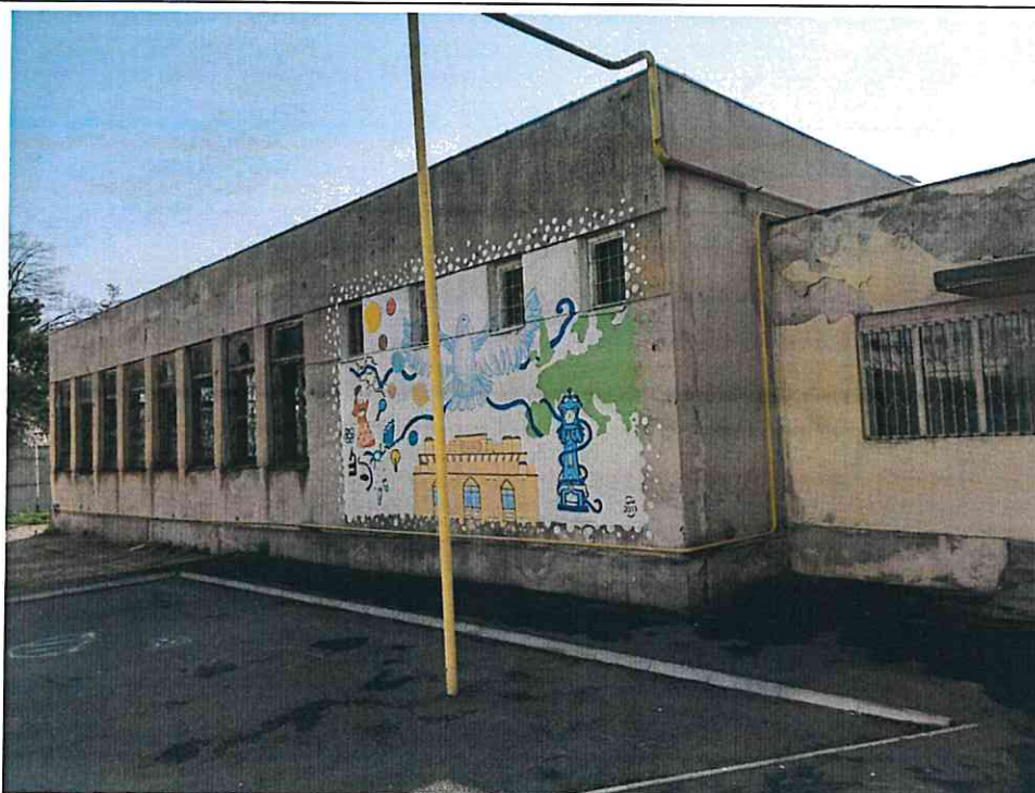
Corp C1 Cantina – vedere spate
