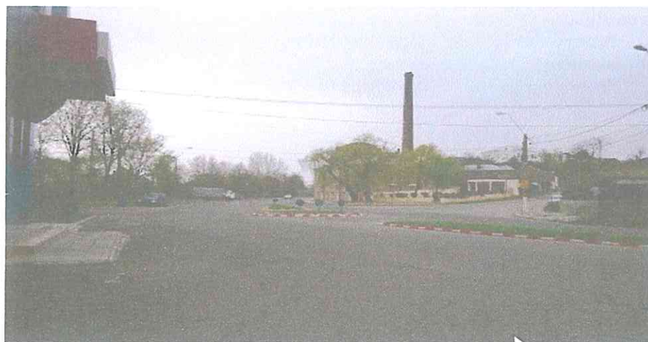
INTERSECTIA STR.DANUBIULUI/ STR. ANGHEL SALIGNY
