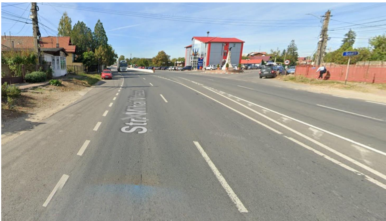
Foto 2. Intersecție DN 1B cu DJ 102E (strada Văleanca), vedere spre Ploiești - Sursa Google Earth
