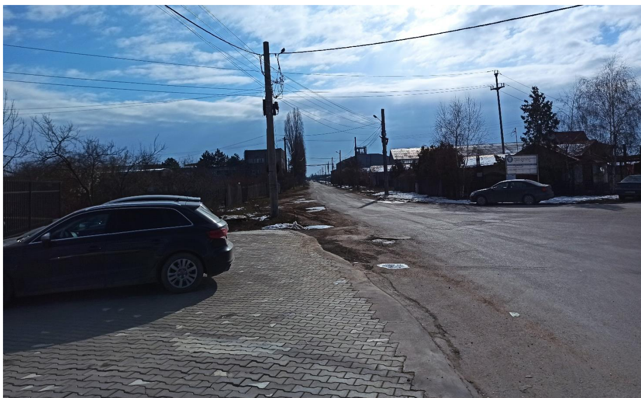
Foto 8. DC 59 (strada Gloriei), la intersecție cu DN 1A vedere spre DJ 250 (strada Bucovului)
