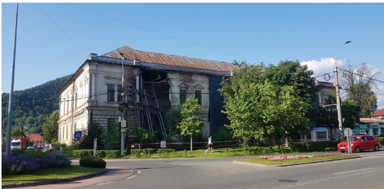
Fig. 4 - Fațada principală a clădirii monument.
