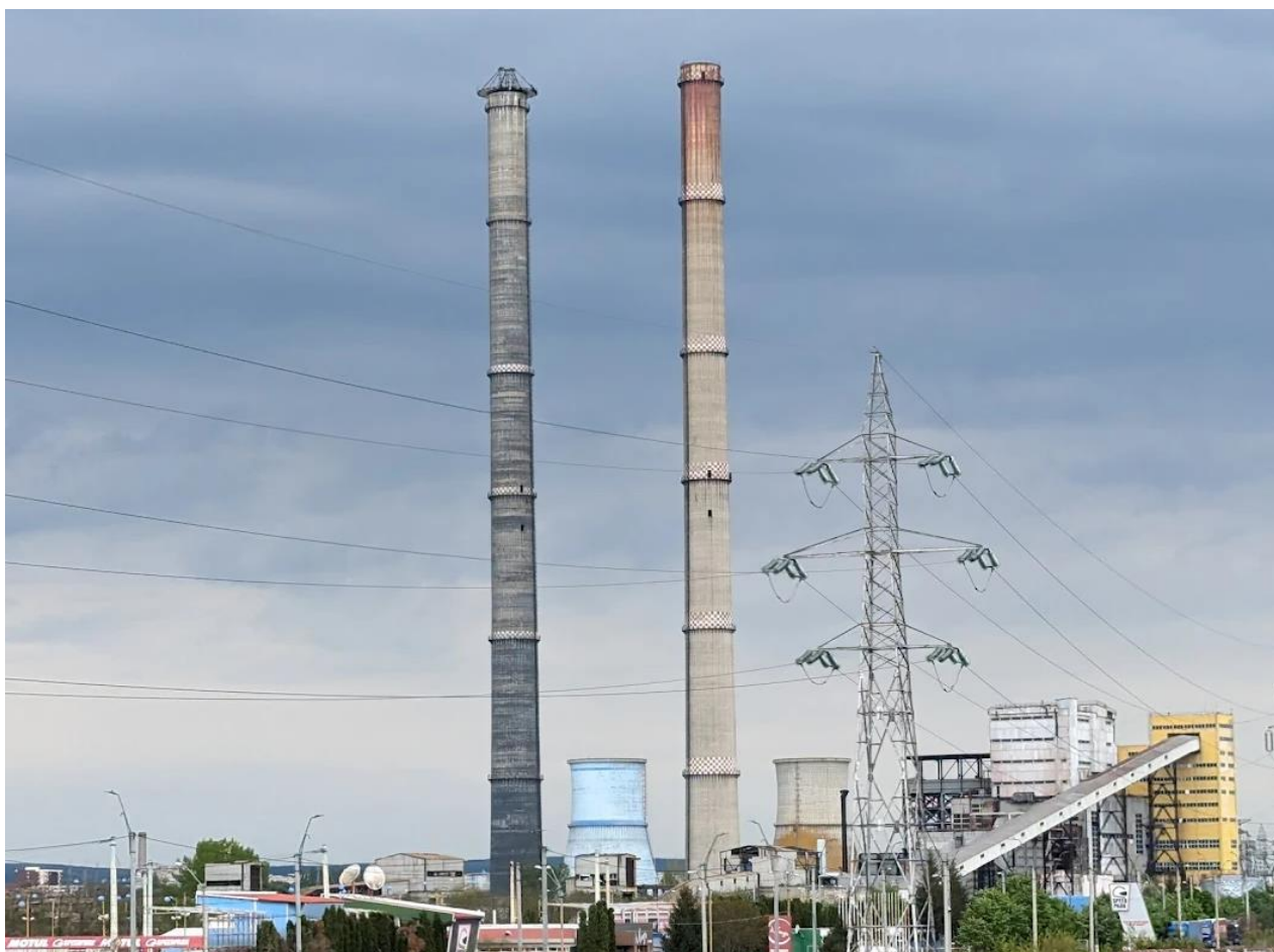
Fig. 5.15. SC Thermoenergy Goup SA Bacău – Centrala Electrică de Termoficare urbană (CET Bacău) (Sursa: https://www.google.com/search?sca_esv=07c43240408ed118&q=Thermoenergy+bacau )
