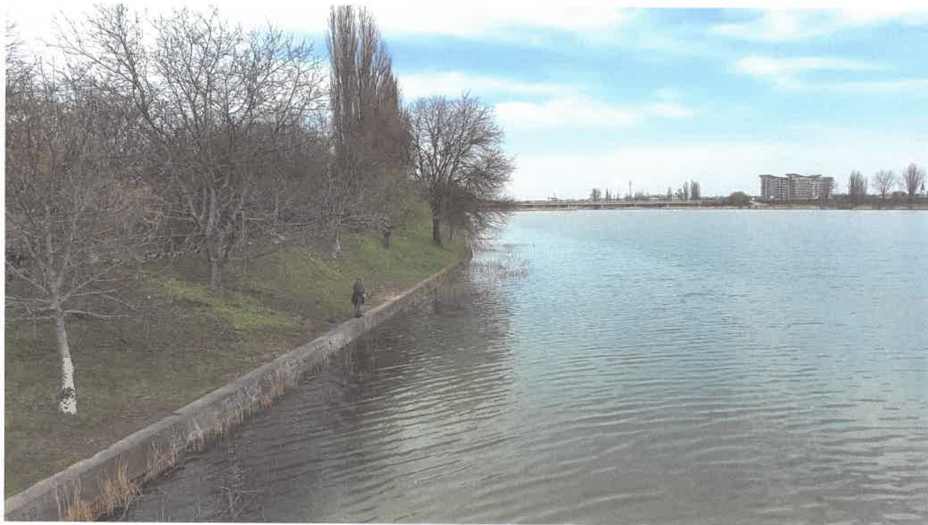
Fig. 6. Fotografie dig protejat cu pinten din beton (295m in zona centrala)
