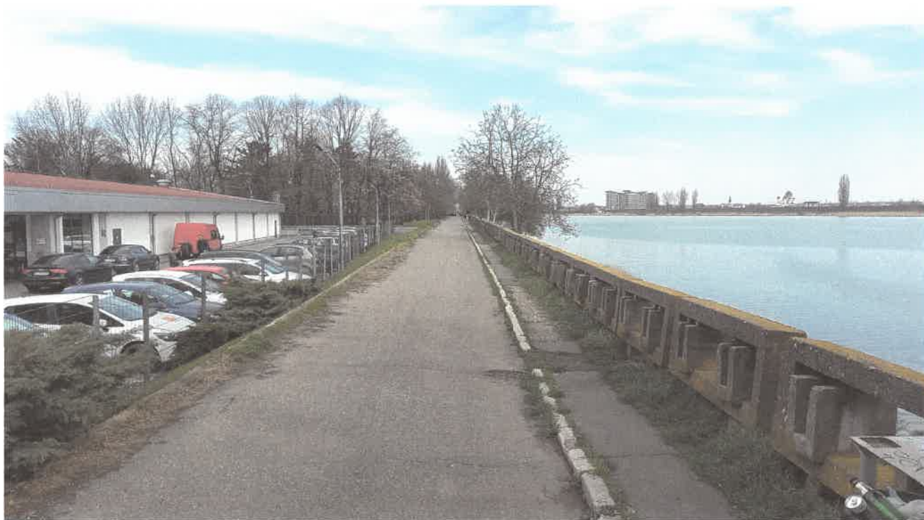
Fig. 1. Coronament amenajat cu asfalt (970m in zona amonte)
