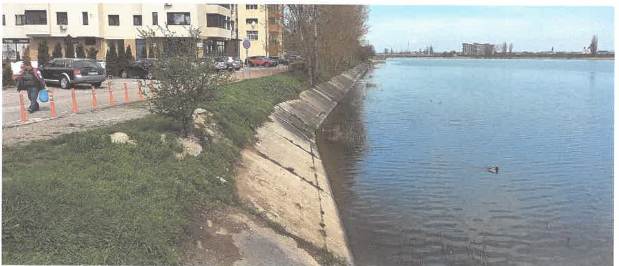
Fig. 9. Pereu din beton in zona centrala
