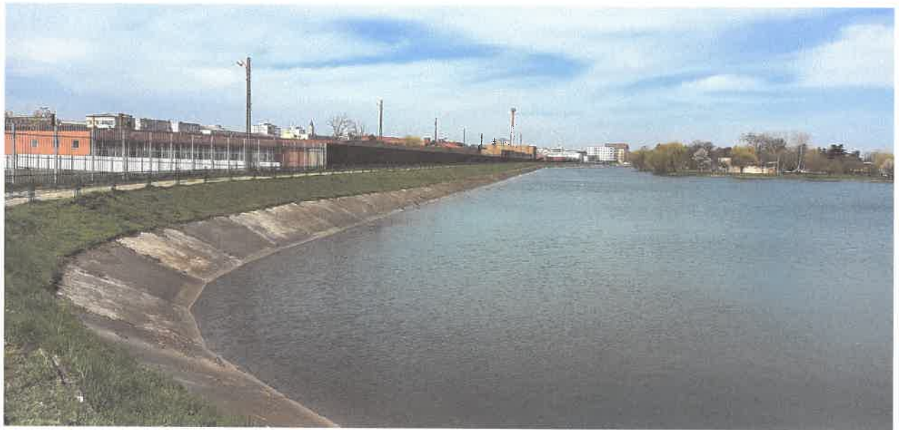
Fig. 8. Pereu din beton in zona aval
