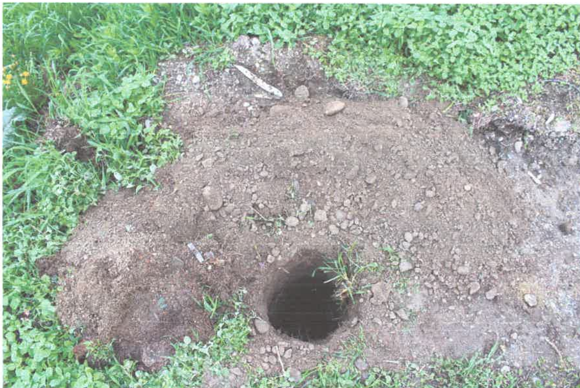
Foto 1 – Succesiunea litologică interceptată în forajul geotehnic numarul 1
