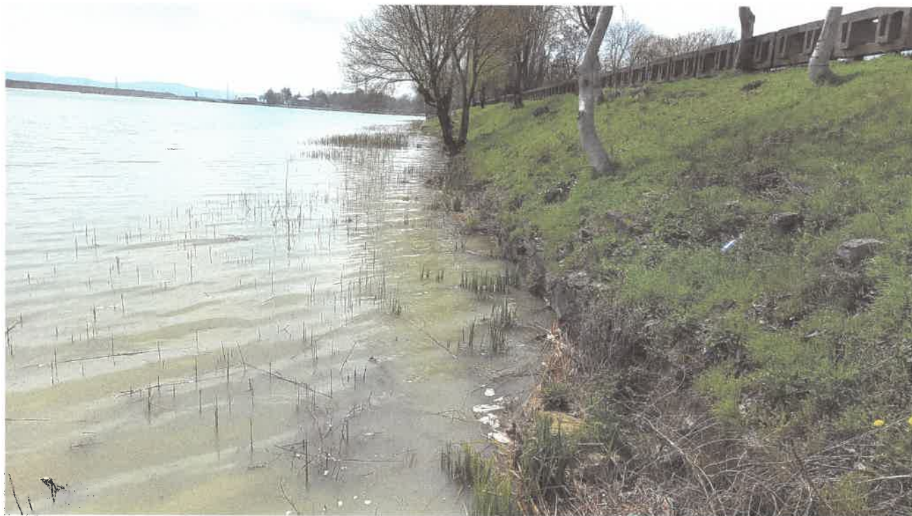
Fig. 4. Fotografie dig protejat cu anrocamente (465m în amonte)
