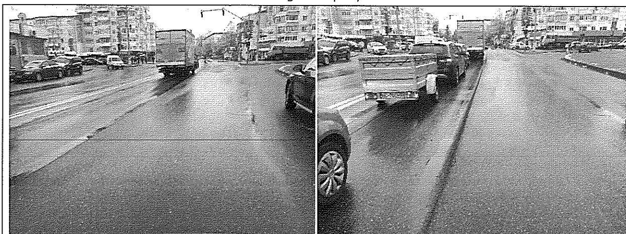
Strada Aeroportului pe zona intersecției cu Bdul.Republicii - cedări pe zona de oprire la semafor
