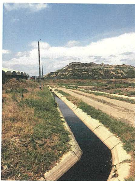
Fig. 3 – vedere rigola perimetrală
