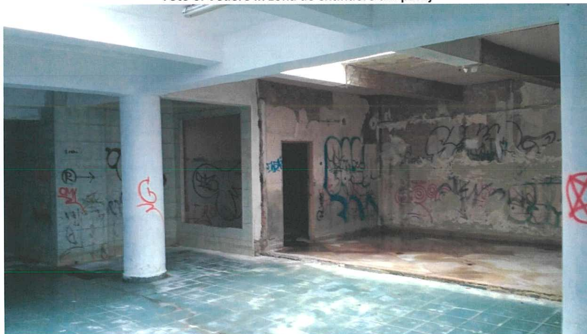
Foto 6: Vedere in zona de extindere din pasaj
