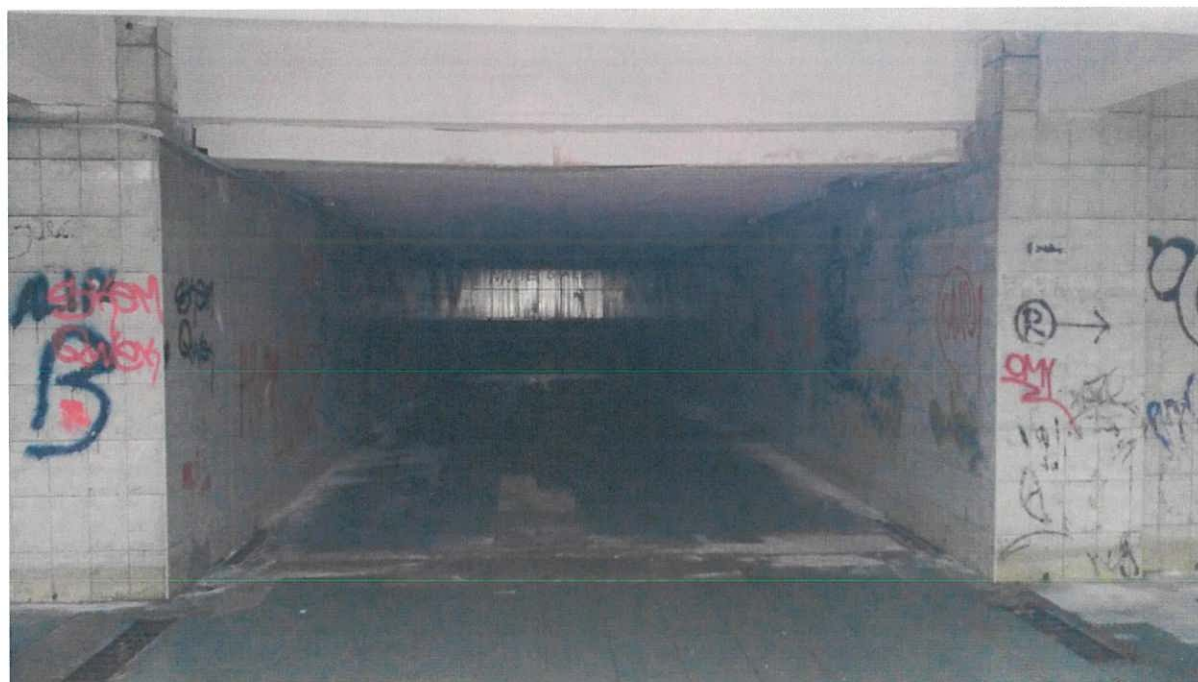
Foto 8: Vedere pasaj dinspre zona de extindere spre accesul in gara
