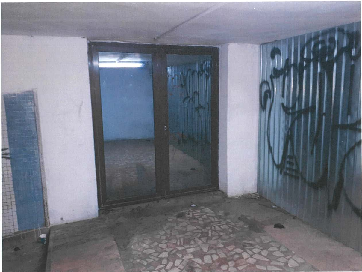
Foto 9: Vedere acces in incinta garii
