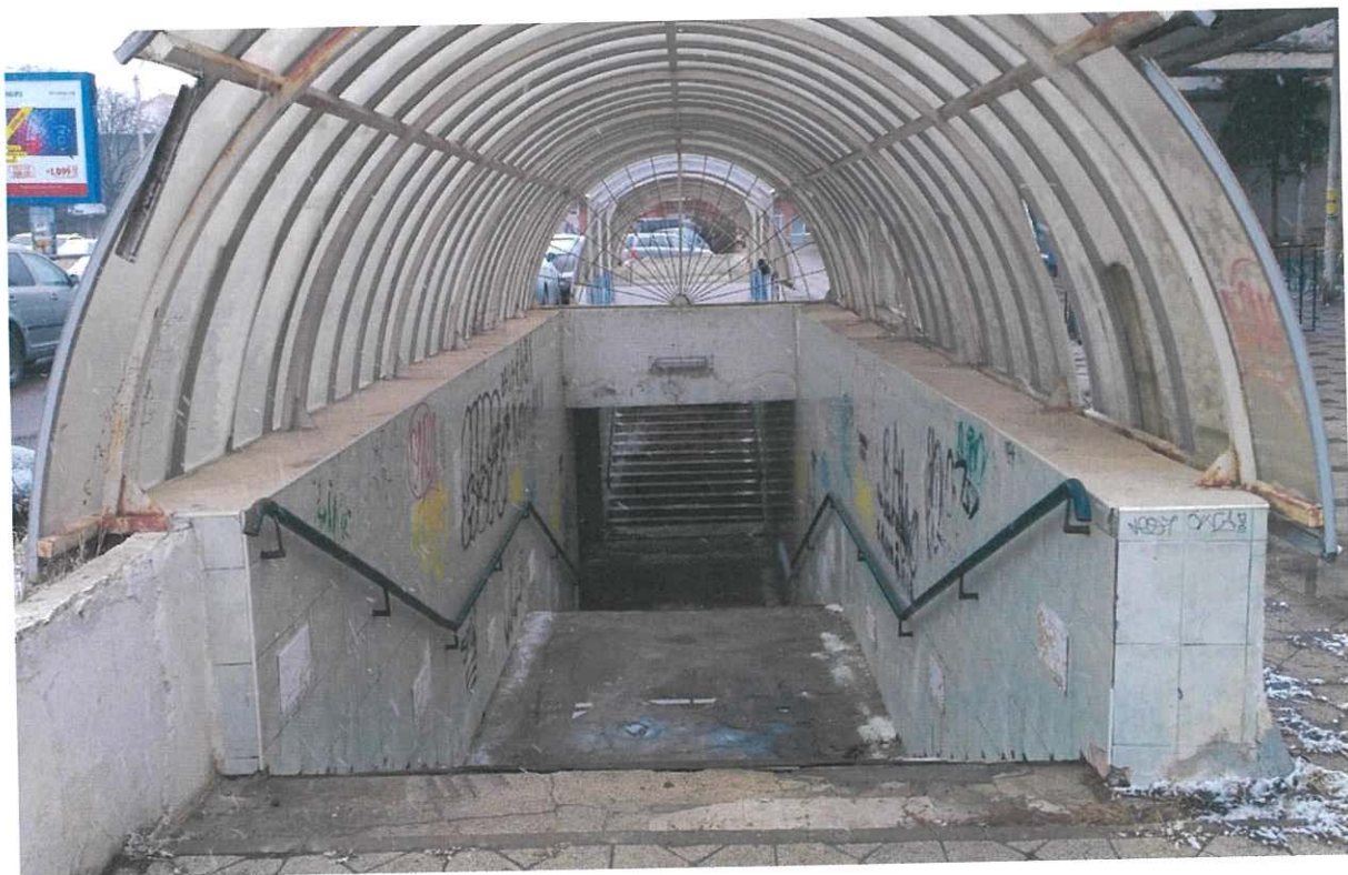
Foto 1: Vedere acces in pasaj, rampa dinspre strada Piata Garii
