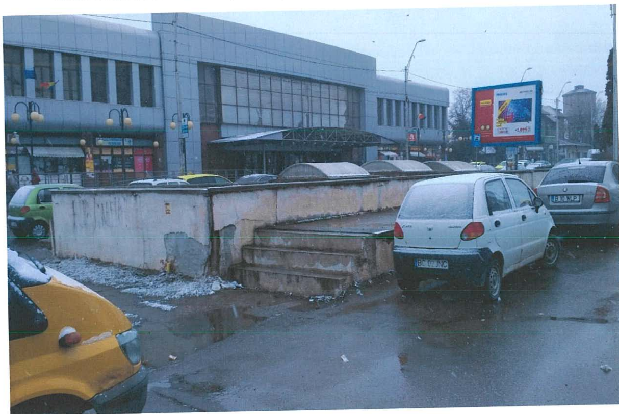
Foto 2: Vedere subterana planseu peste zona de extindere din pasajul subteran
