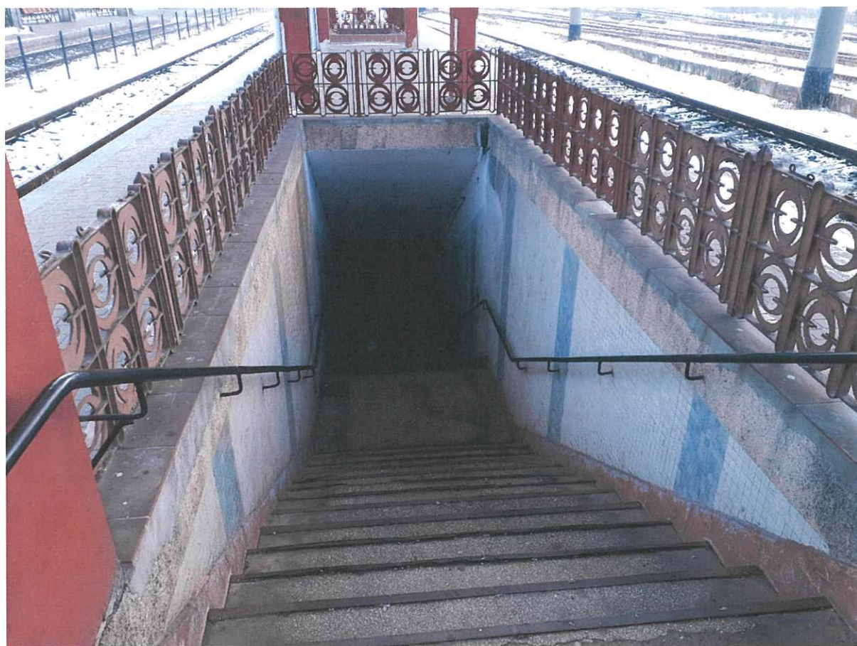
Foto 13: Vedere acces de pe peroanele dintre linii de cale ferate
