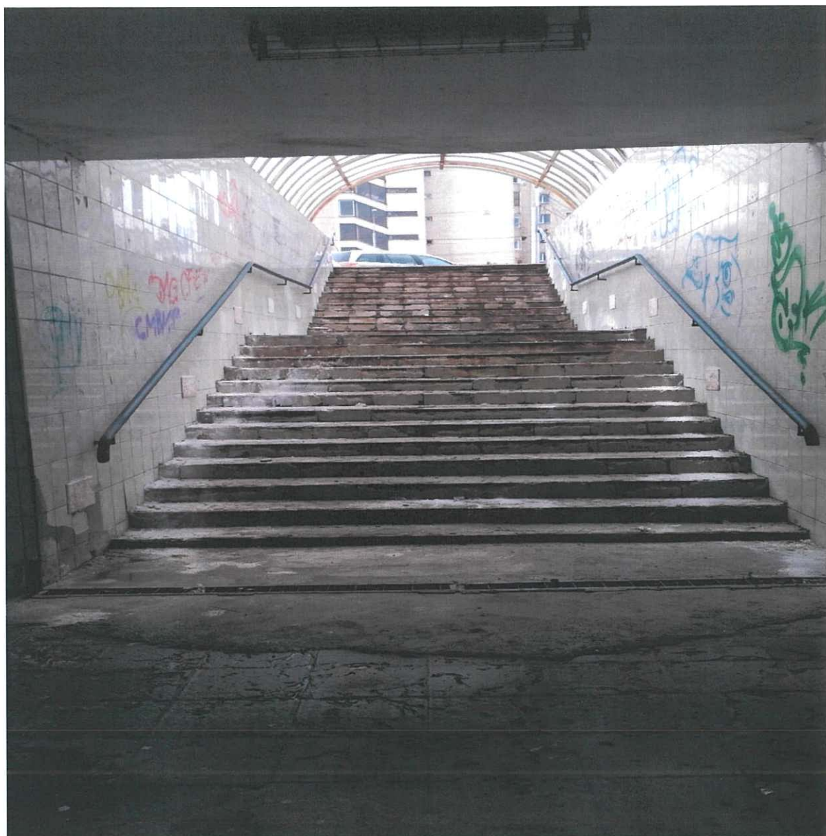
Foto 3: Vedere scari de acces in pasaj dinspre strada Piata Garii
