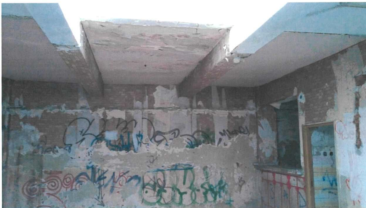
Foto 7: Vedere intrados planseu in zona iluminatoarelor pasajului subteran
