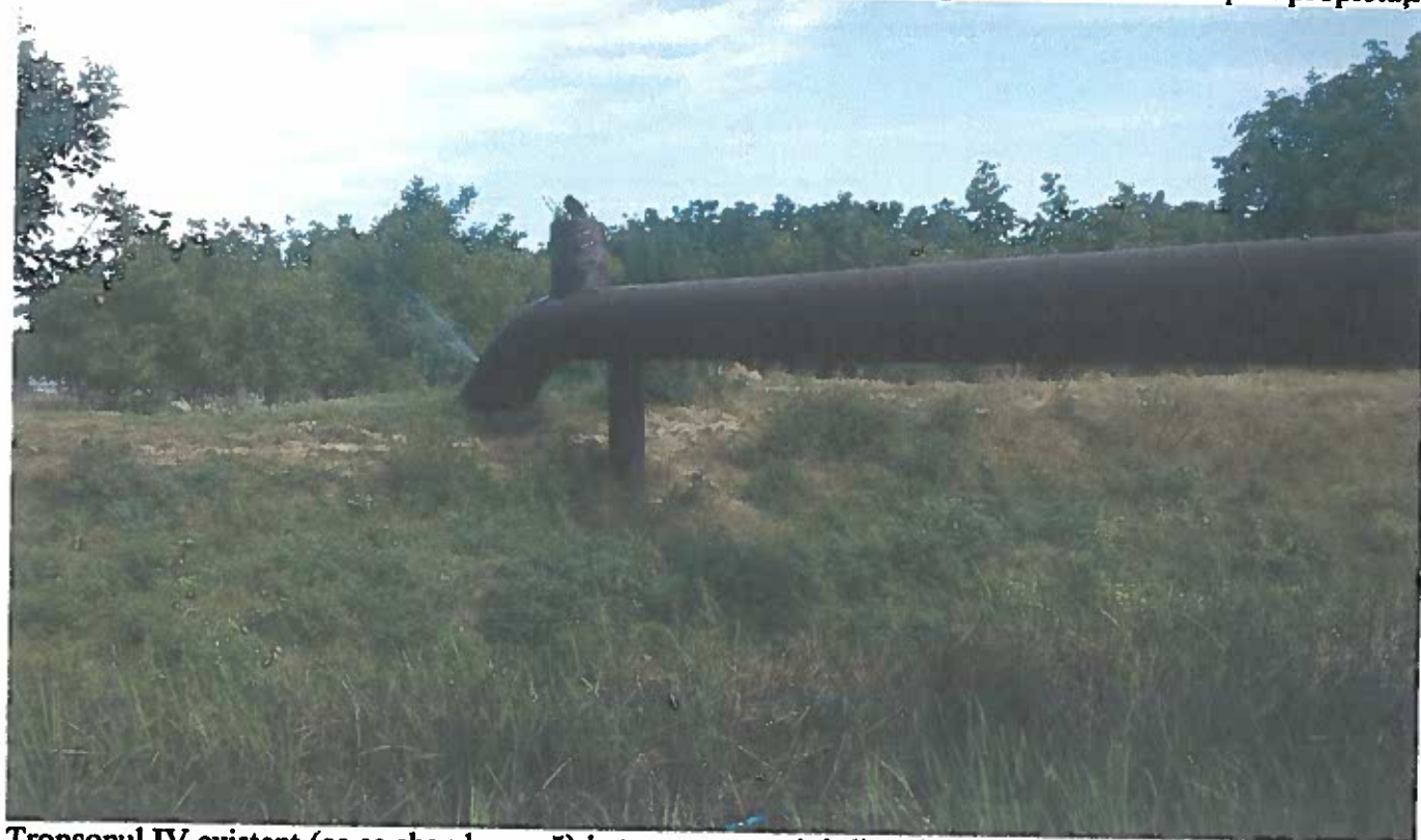
Tronsonul IV existent (ce se abandonează) la traversarea pâraului Digul Bârnat cu trecere prin proprietăți
