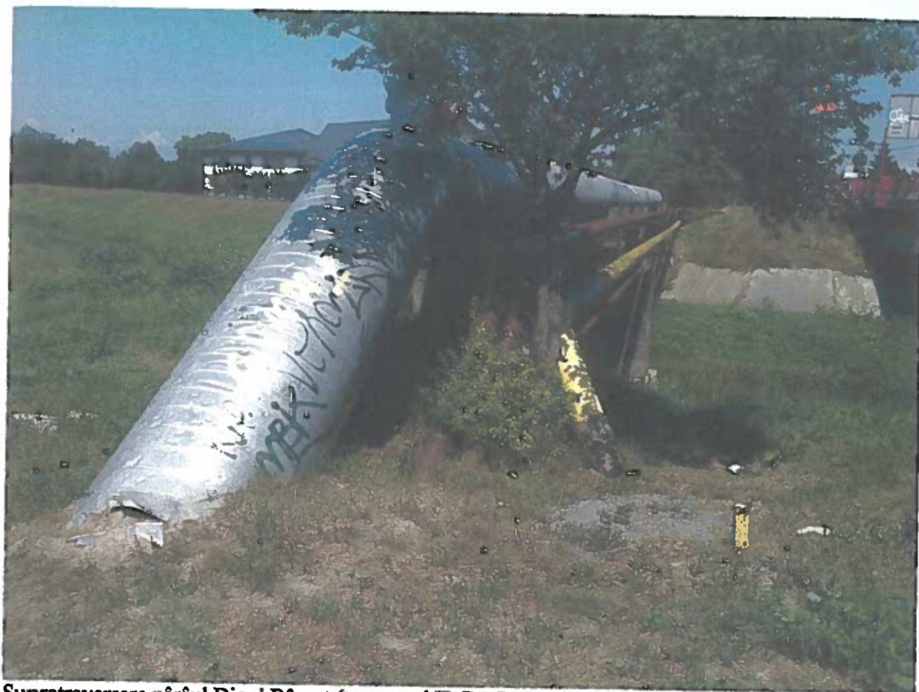
Supratraversare pârâul Digul Bârnat (tronsonul II, Dn 700, existent) utilizată prin proiect
