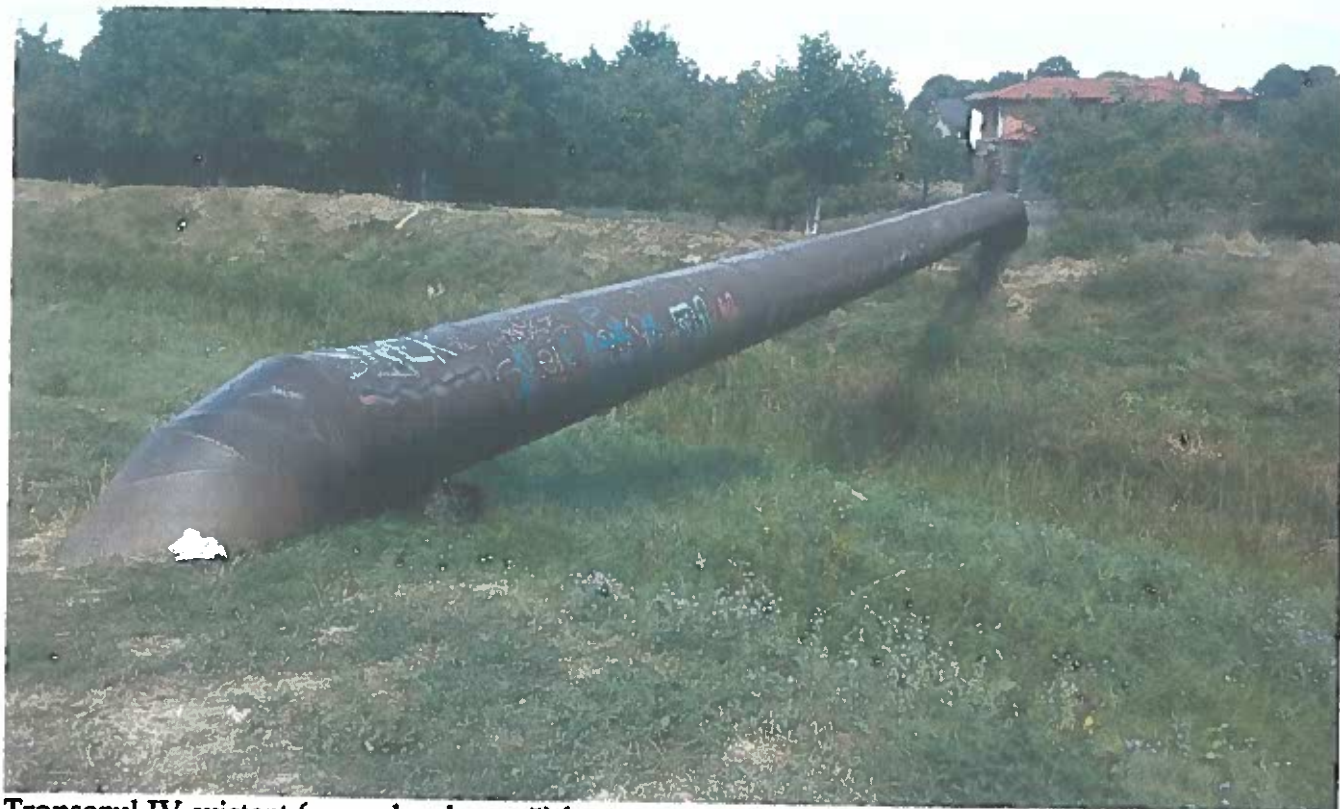
Tronsonul IV existent (ce se abandonează) la traversarea pâraului Digul Bârnat cu trecere prin proprietăți
