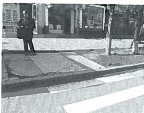
Figura 84: Situații de inaccesibilizare a spațiilor publice pentru persoanele cu mobilitate redusă. (stg.) Necorelare între rampa de accesibilizare și trecerea pentru pietoni (dr.)
