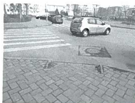
Figura 84: Situații de inaccesibilizare a spațiilor publice pentru persoanele cu mobilitate redusă. (stg.) Necorelare între rampa de accesibilizare și trecerea pentru pietoni (dr.)
