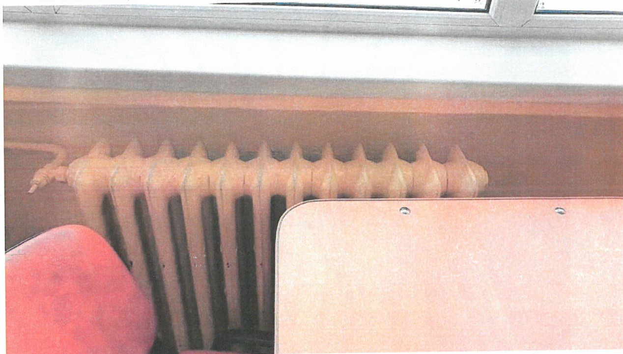
Corp C1 – Radiator de fonta fara elemente de reglaj (tur-retur)
