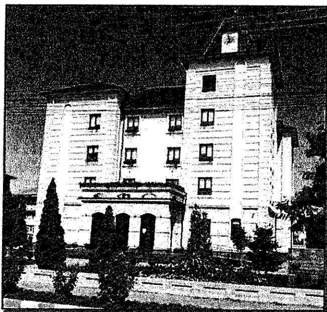
Fig. 2: Fațada principală – spre strada Alexandru Ioan Cuza
