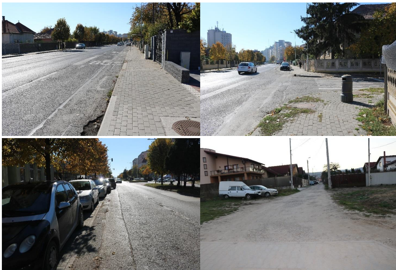
Figura 2.24. Străzi a căror suprafață de rulare se află în stare tehnică proastă (Exemplificare).
