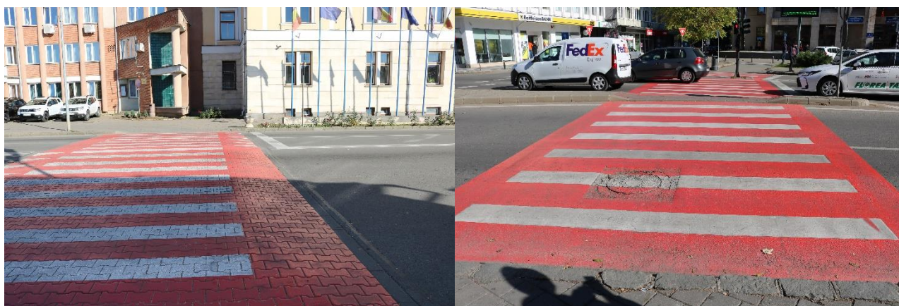
Figura 2.80. Treceri de pietoni accesibilizate (Exemplificare).
